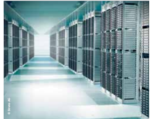
Kyl- och klimatanläggningar
